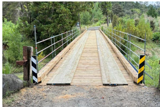
Lovatt Road Bridge
